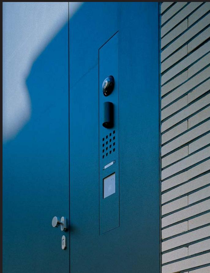
Die Montageebene wird so weit versenkt, dass die Bedienebene exakt bündig mit der umgebenden Fläche abschließt. Überstände nach vorn entstehen nur, wo es die Funktion erfordert – beispielsweise bei der Videokamera und der Spotbeleuchtung. Die Anlage im Bild ist wie das umgebende Türpaneel mit dem extrem widerstandsfähigen und schmutzresistenten Duraflon beschichtet.
